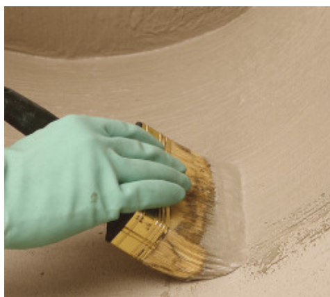
Στεγάνωση λεπτομερειών με βούρτσα
