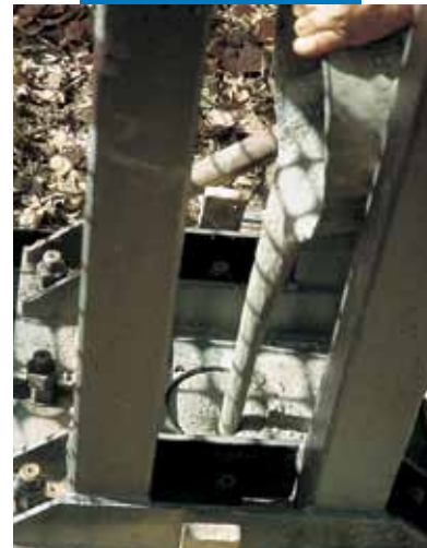
Αγκύρωση μεταλλικού σκελετού με Mapefill
